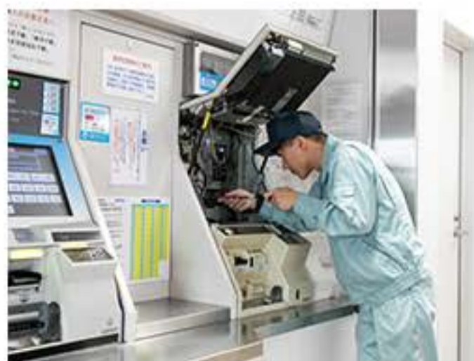
自動券売機の定期検査
