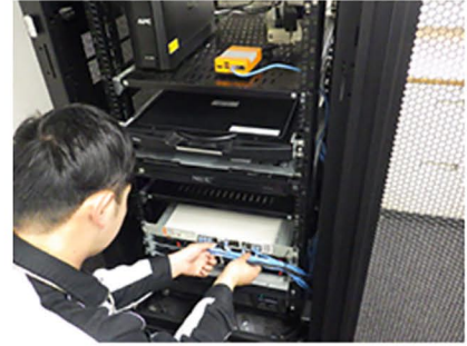
ネットワーク配線・機器設置工事
