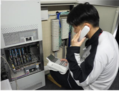
電話交換機設備の設置工事
