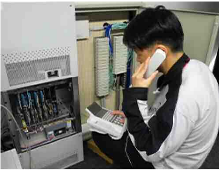
電話交換機設備の設置工事
