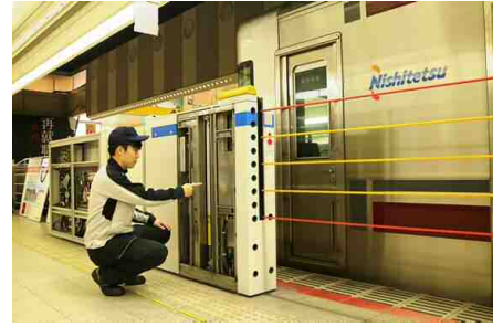
ホーム柵工事
