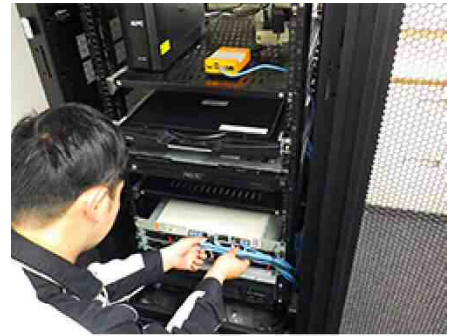
ネットワーク配線・機器設置工事
