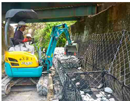
橋脚改良工事
