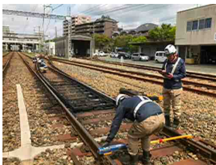
軌道の定期検査
