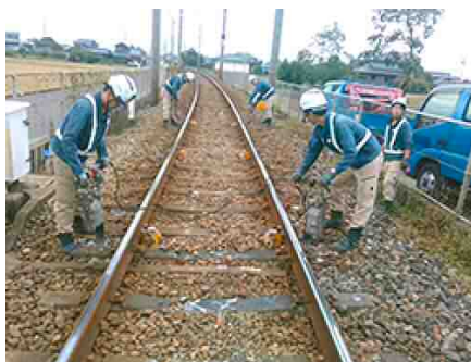
軌道の補修工事
