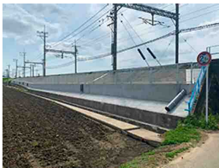
法面改良工事
